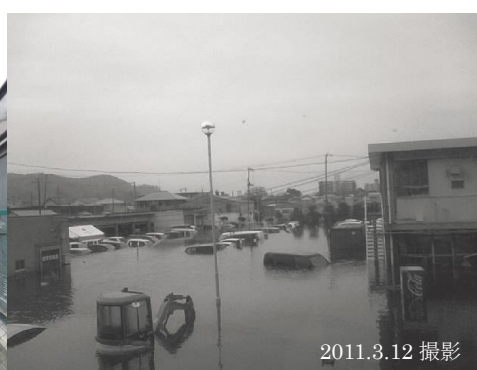
図4 石巻合庁冠水状況 4)
