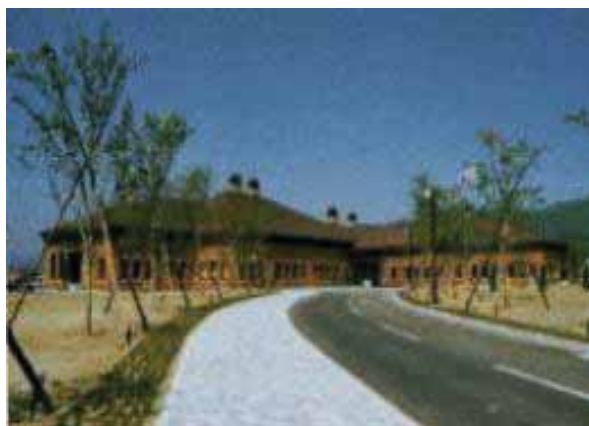
北上川下流流域下水道 石巻浄化センター
