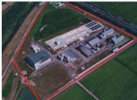
吉田川流域下水道 大和浄化センター
