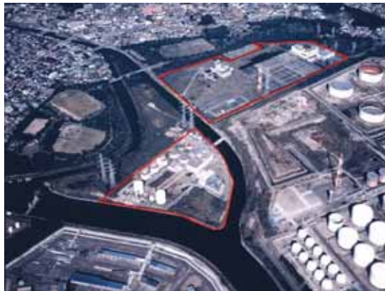
仙塩流域下水道 仙塩浄化センター
