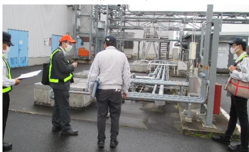
設備の現地確認
