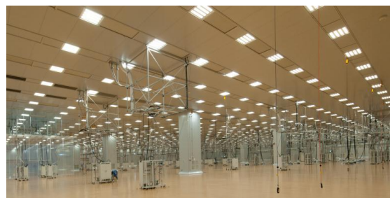
↑ 生産棟クリーンルーム
