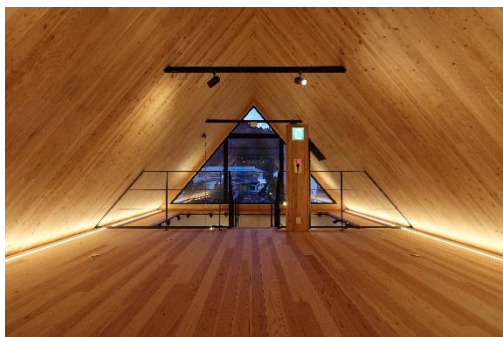
図 32：CLT を用いた建築物の例（三角屋根の内観）
