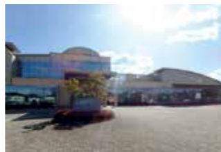
ZEB化された角田市総合保健福祉センター
