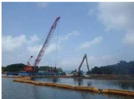
復旧工事施工中の状況
