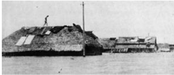
鳴瀬川鹿島台町志田谷地堤防決壊による浸水
