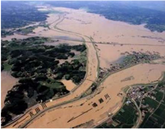
鳴瀬川吉田川併流部浸水状況
