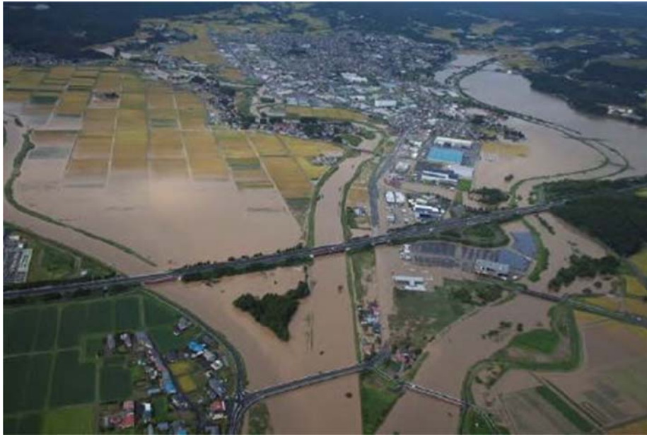
吉田川上流部の浸水状況 (吉田川・竹林川・善川合流部)
