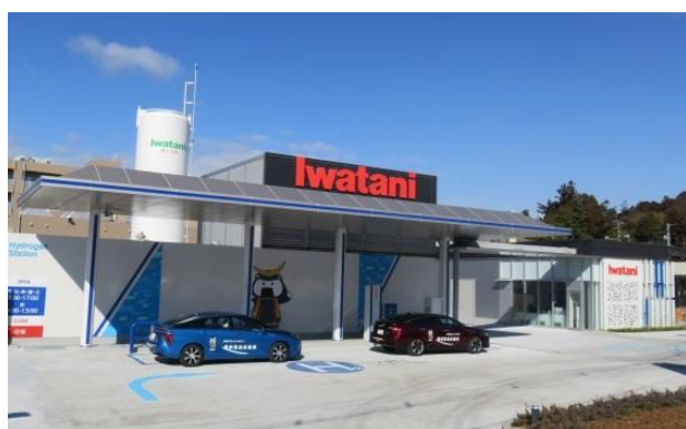
参考図 4.33 商用水素ステーション
