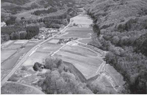
▲ ほ場整備・七ヶ宿2期地区（七ヶ宿町）
