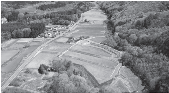
▲ほ場整備・七ヶ宿2期地区（七ヶ宿町）
