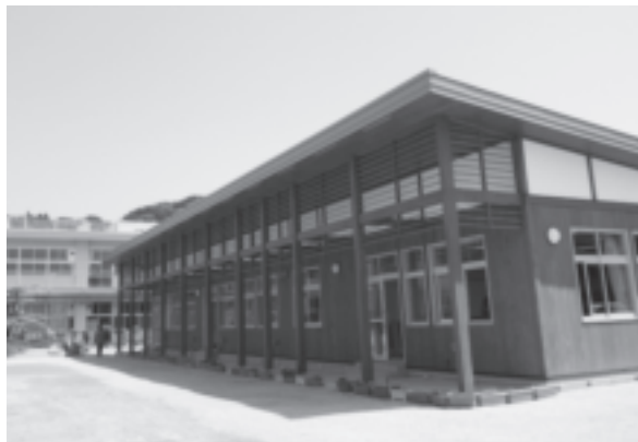
▲県産材を使用した木造公共施設
