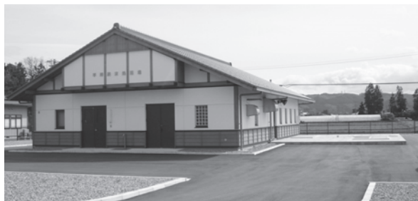
▲平塚地区汚水処理施設（登米市）
