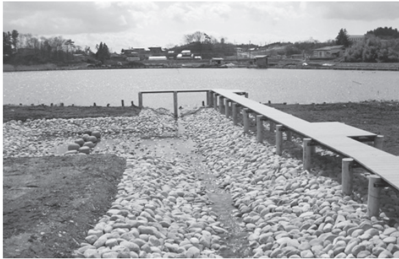
▲農業用ため池に整備した生態系保全型水路と環境管理用デッキ（登米市・機織沼）
