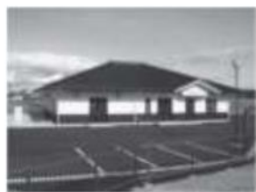
田尻第2地区汚水処理施設 (大崎市)
