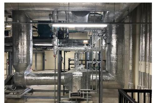
▲排ガス回収熱交換器
