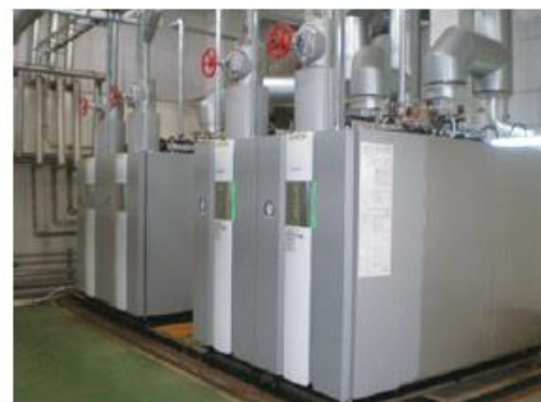
▲平成29、30年度補助事業により ボイラー4機を更新
