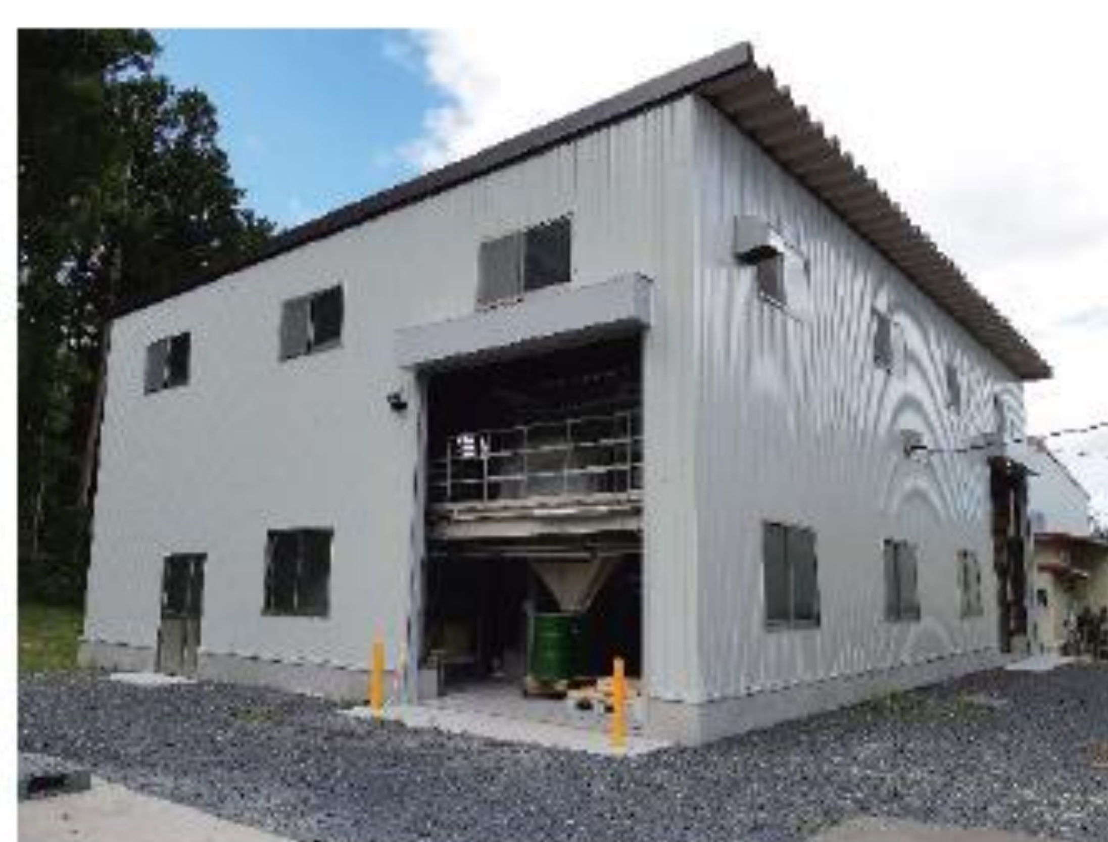
▲排水処理設備外観
