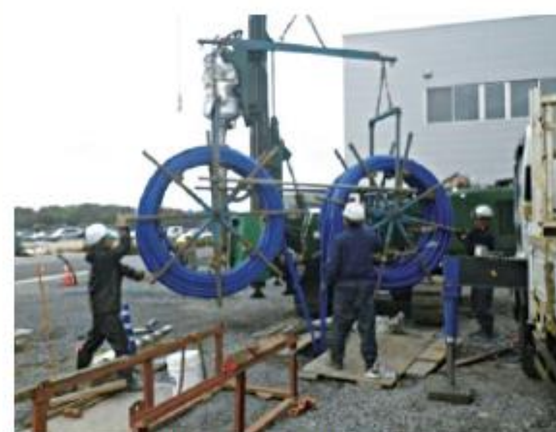
▲地中熱交換器施工状況 (築館工場)
