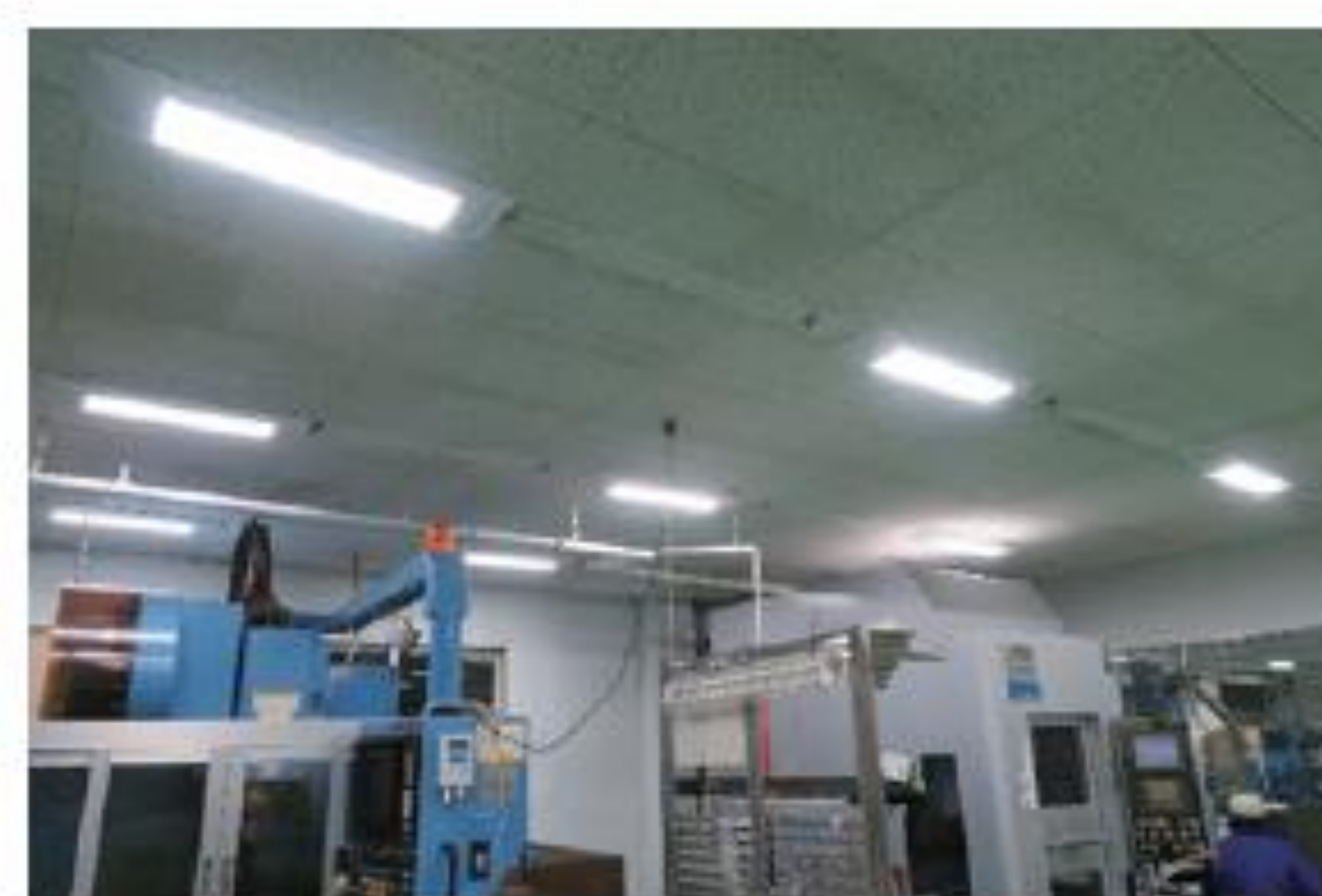
▲LED照明 合計298台更新
