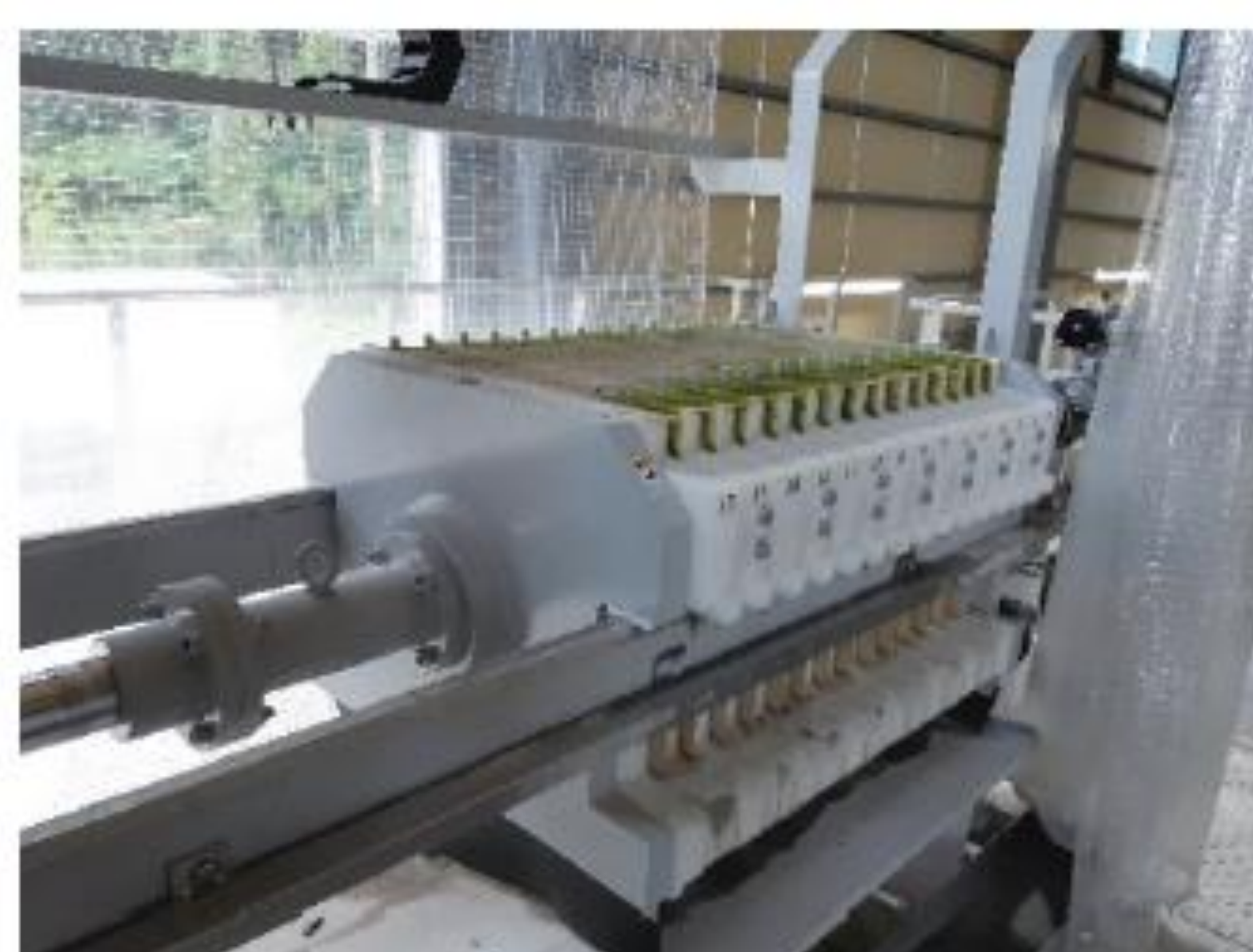
▲全自動汚泥脱水機
