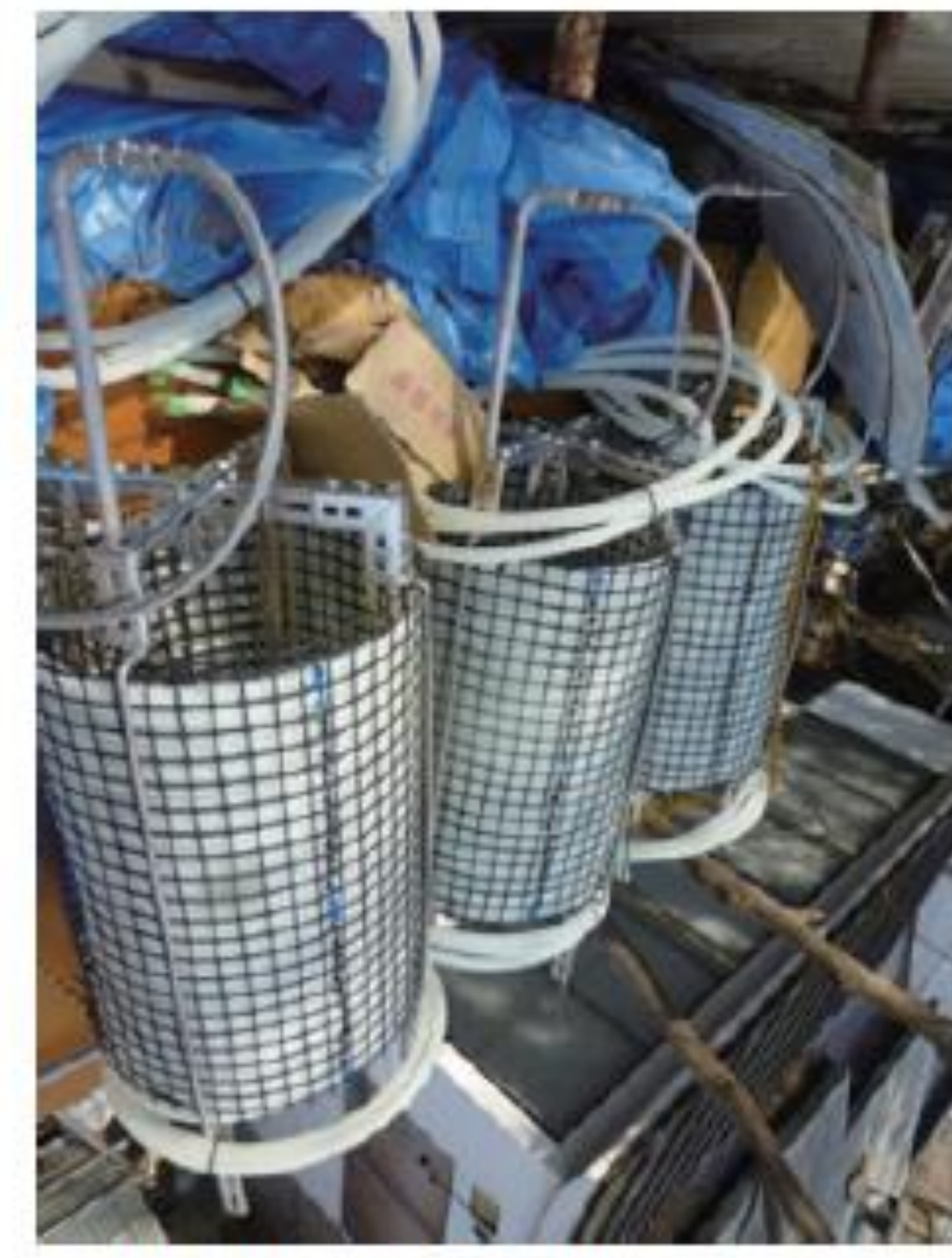
▲導入した樹脂管製熱交換コイル
