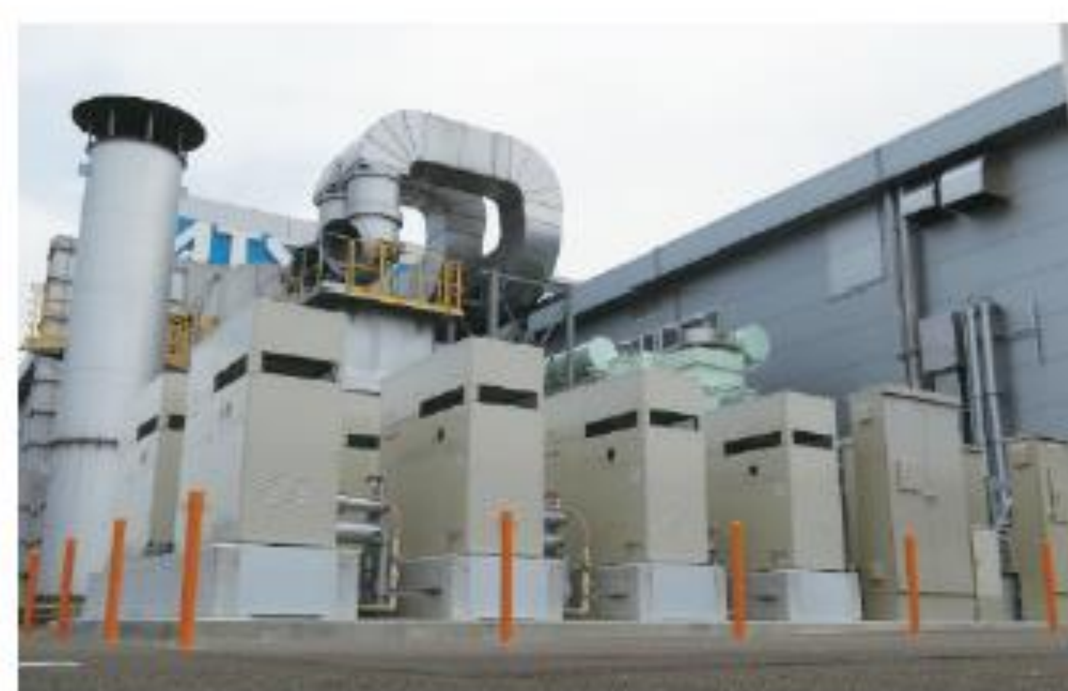
▲停電対応型マイクロガスCGS
