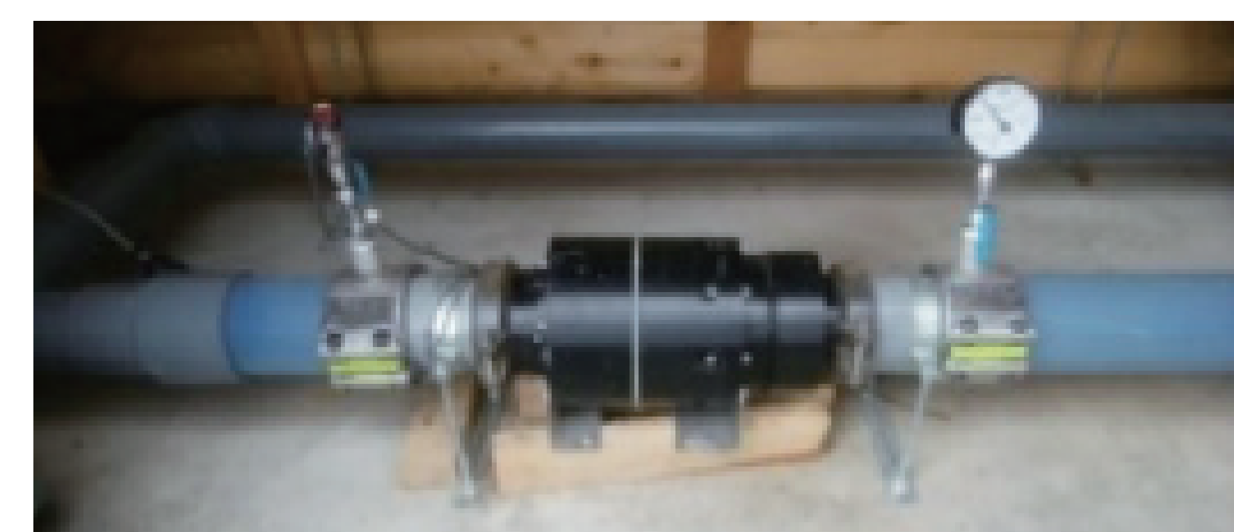
▲デジタル圧力計で水量をデータ化（蔵王町）
