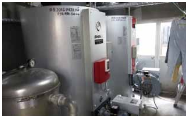
▲導入設備の例 (高効率ボイラー)
