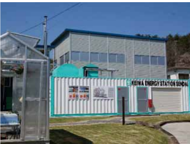
▲ケイワ・エネルギーステーション仙台
