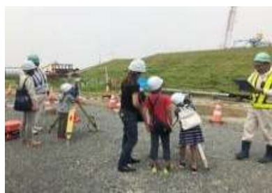
建設現場見学会
