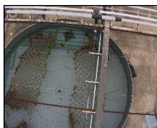
図 3a. 屋外水槽空撮画像 (光学カメラ)
