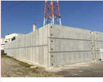
ボックスカルバートの設置
