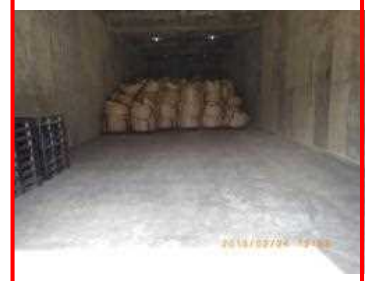
コンクリート構造の堅固な 既存の施設へ移送
