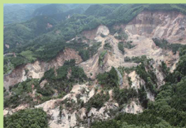
荒砥沢ダム崩落現場【栗原市】
