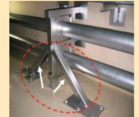
主蒸気配管(左)・建屋内配管(右)の耐震補強
