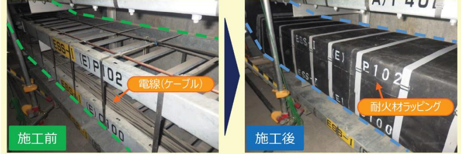
【順次実施している「ケーブルトレイへの耐火材ラッピング工事」】
