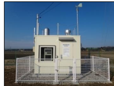
広域モニタリングステーション
