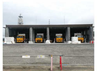
● ガスタービン発電装置
