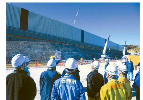
● 立入調査の様子
