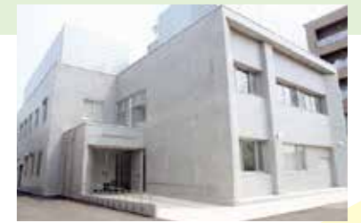
④ 環境放射線監視センター再建
