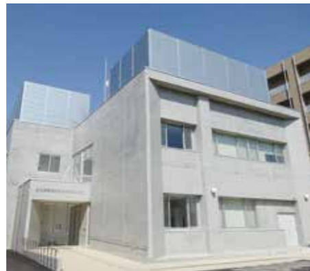
宮城県環境放射線監視センター(仙台市)
