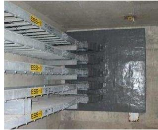
止水ダンパの設置(新設:壁貫通ダクト)
