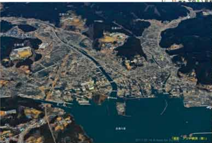
南三陸町 志津川周辺の被災状況
