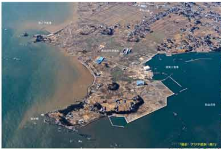
気仙沼市 岩井崎の被災状況
