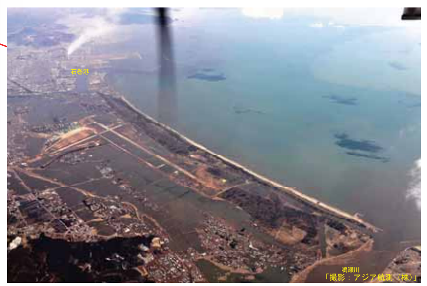
東松島市矢本の被災状況
