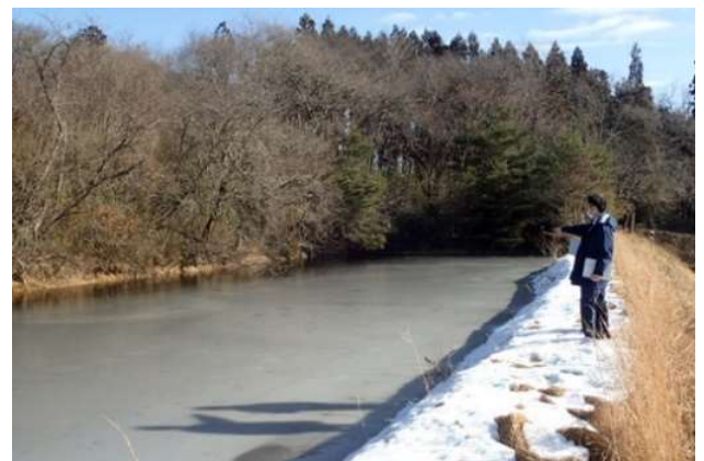
▲防災重点ため池点検の様子 (下板橋2号ため池)
