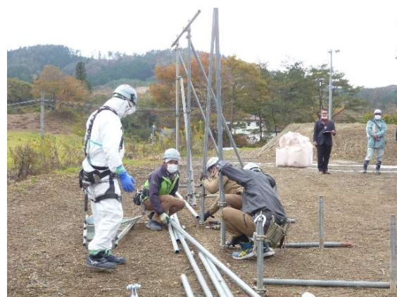
▲防疫フェンス(組立状況)
