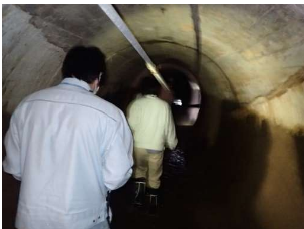
▲調査状況（隧道）
