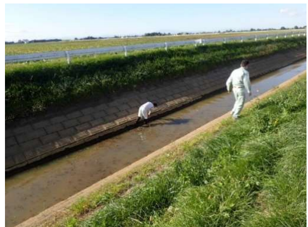
▲調査状況（連結平板ブロック）
